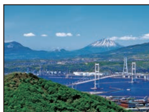
測量山より望む白鳥大橋 (室蘭市)
