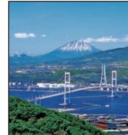
測量山より望む白鳥大橋 (室蘭市)
